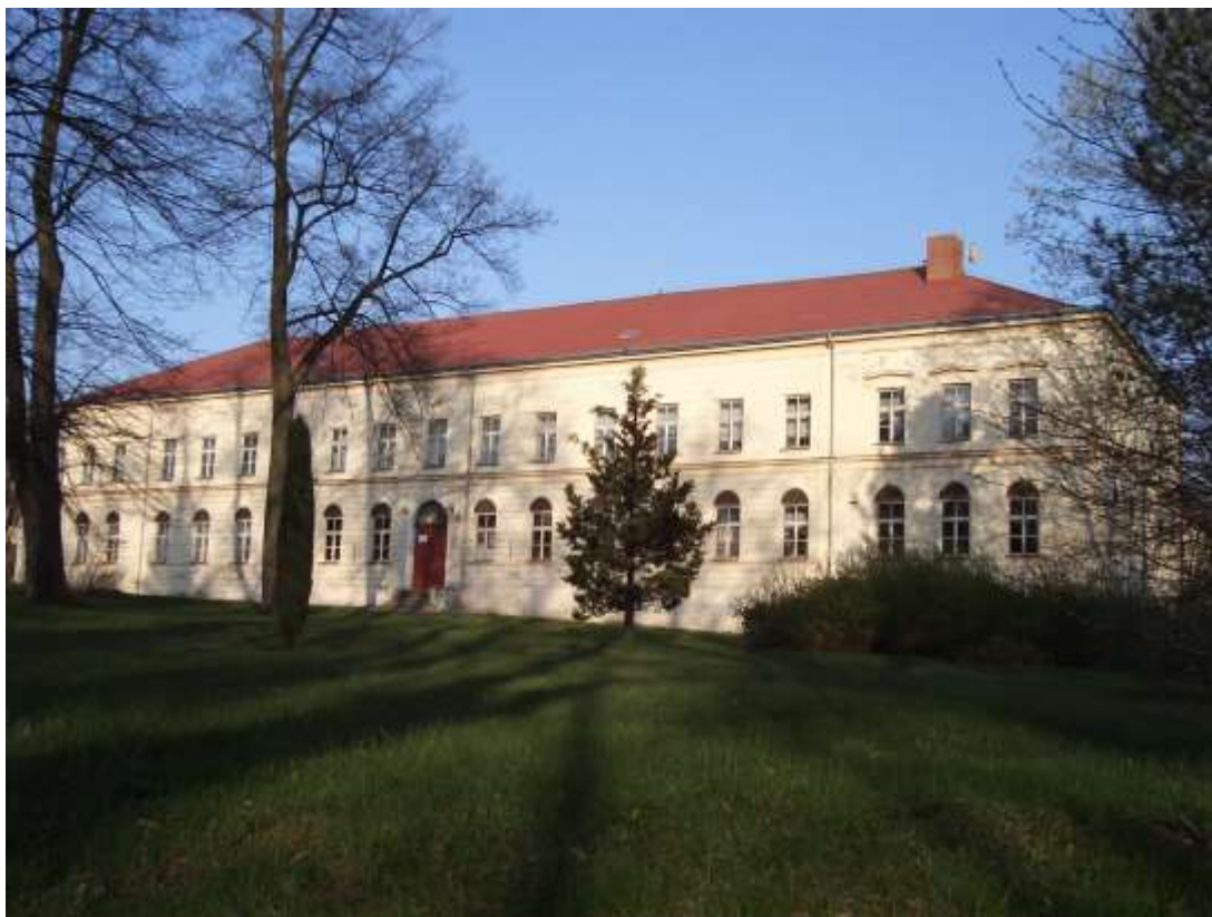
Budova školy v Zámecké ulici, Frýdlant
